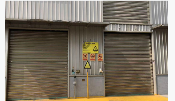
危险废弃物仓库
